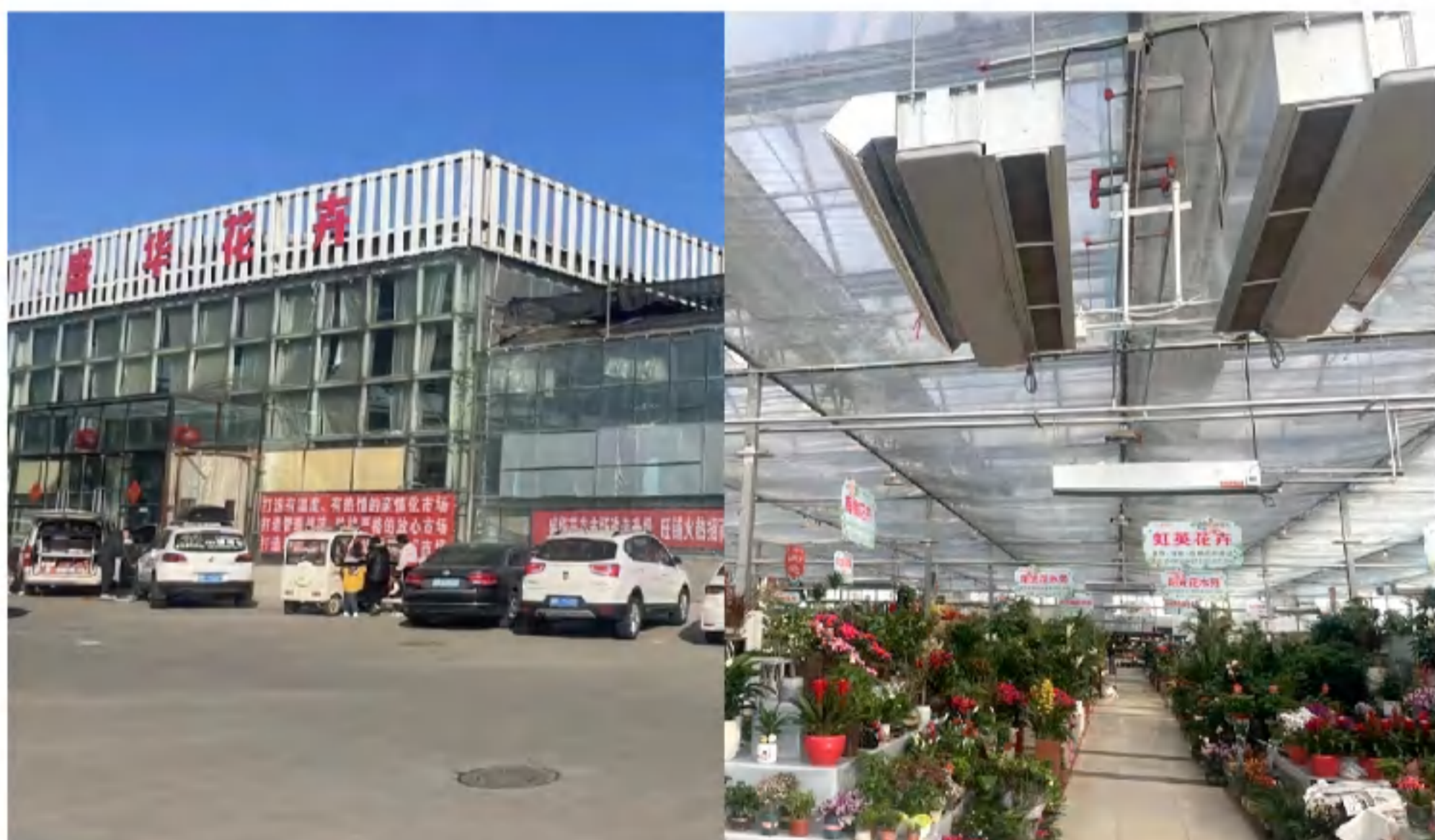
河北盛华集团新建花卉大棚项目
