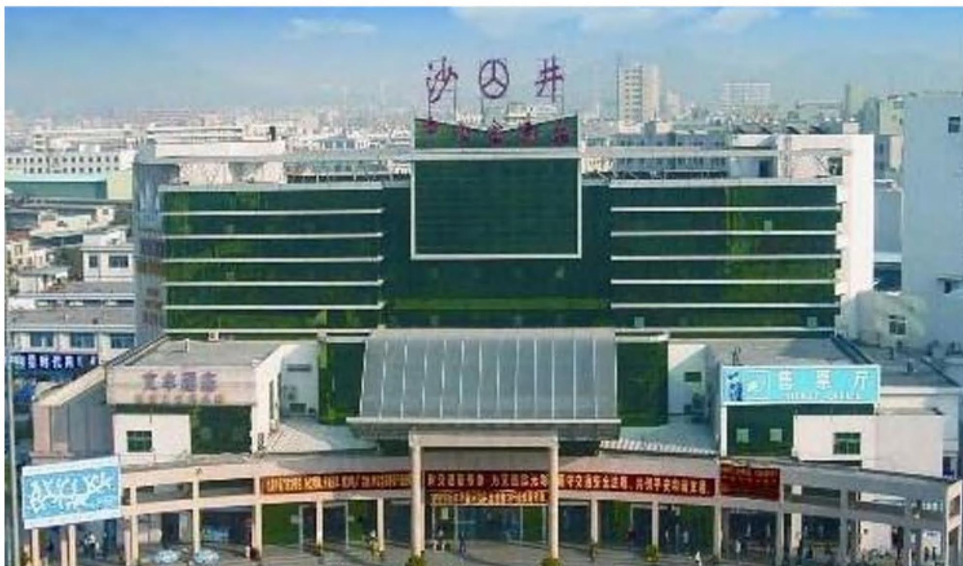
深圳市文丰大厦项目
