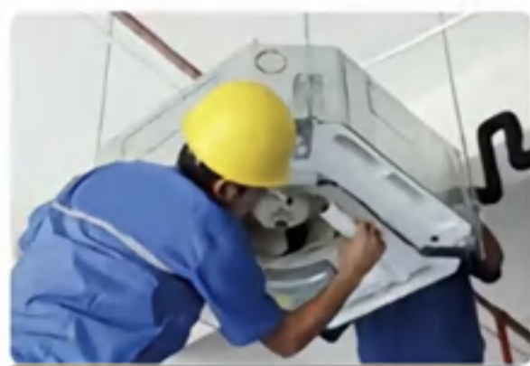
水管连接室内机
