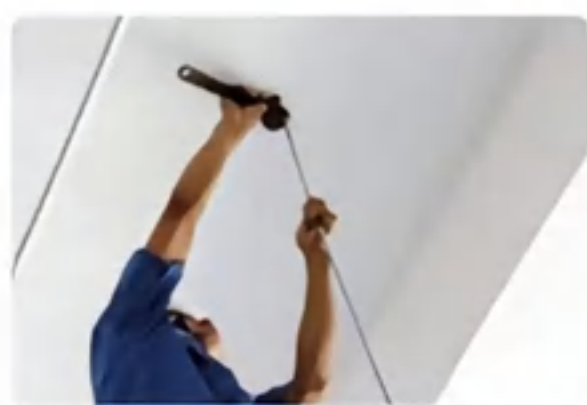
内机吊杆孔定位
