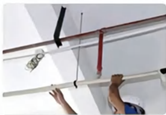
室内机水管固定
