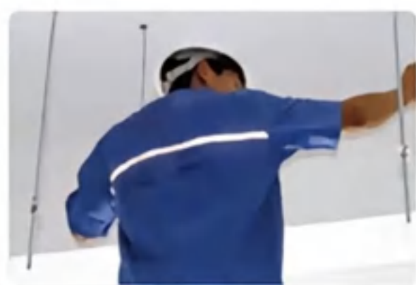
内机吊杆孔安装固定
