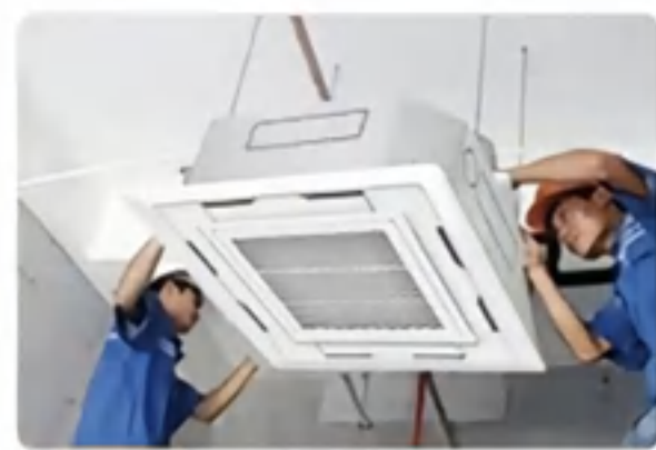
室内机面板安装
