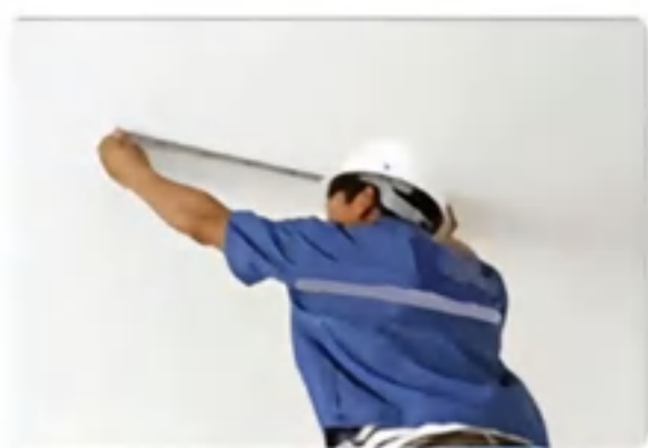
室内机安装定点
