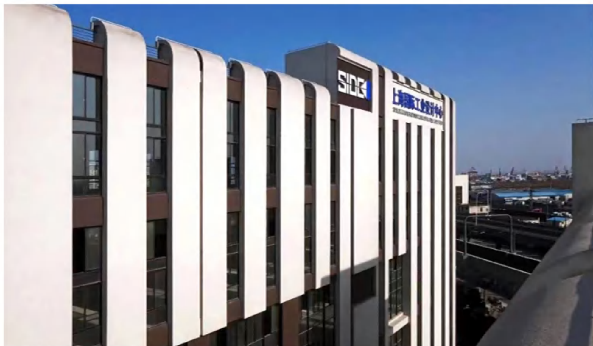
上海国际工业设计中心项目
